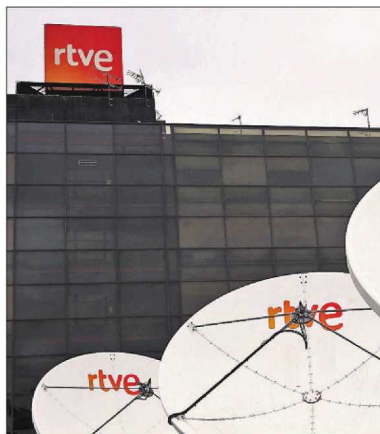
Instalaciones de RTVE en Torrespaña (Madrid).
