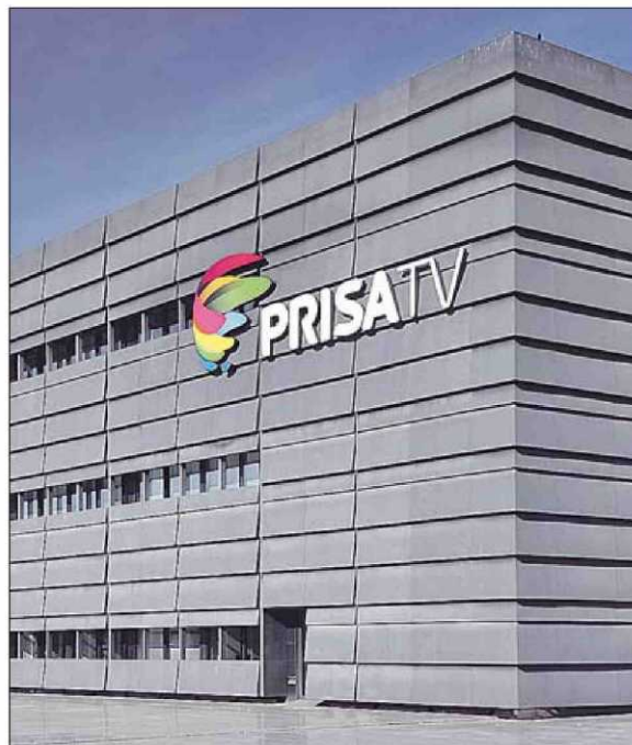
Instalaciones de Prisa TV en Madrid. EE
